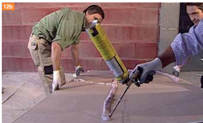
12b. Incollaggio della lastra in cartongesso con il collante Spidigliù.
