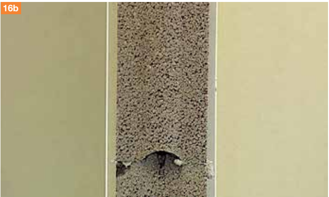
16b. Parete rifinita con lastre di mm 12.5 applicate in ambo i lati.
