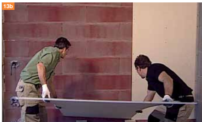
12b. Incollaggio della lastra in cartongesso con il collante Spidigliù.
