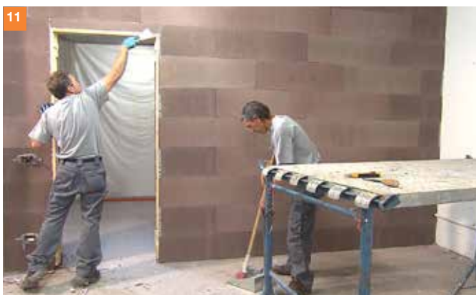
11. Pulizia della parete e dell'ambiente di posa.
